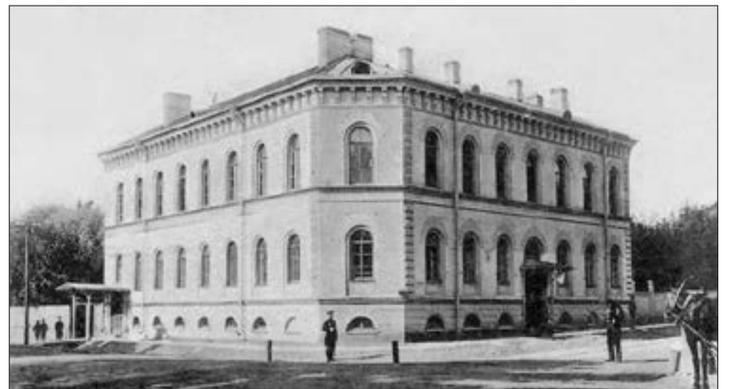
Здание Дворцового управления. Чкалова, д. 77. 1890-1900.
